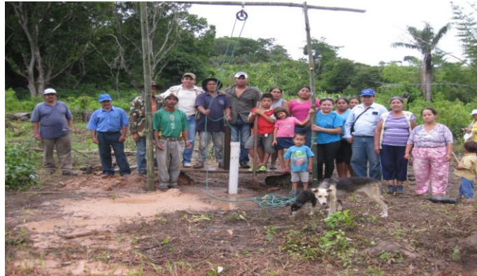
Pozo listo para instalación de bomba rosario
